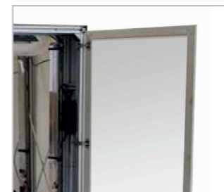
Fermeture porte à clé, contacteur mécanique et détecteur de présence.
